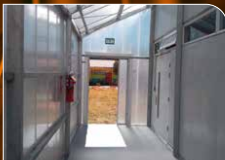
Estructuras para aulas y módulos
